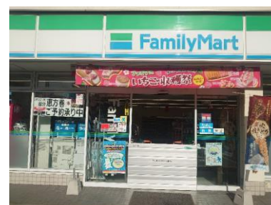
ピア六甲店（止水板設置）
